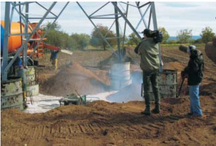
Betonierungsarbeiten am neuen Mast der 110-KV-Leitung der EnBW
