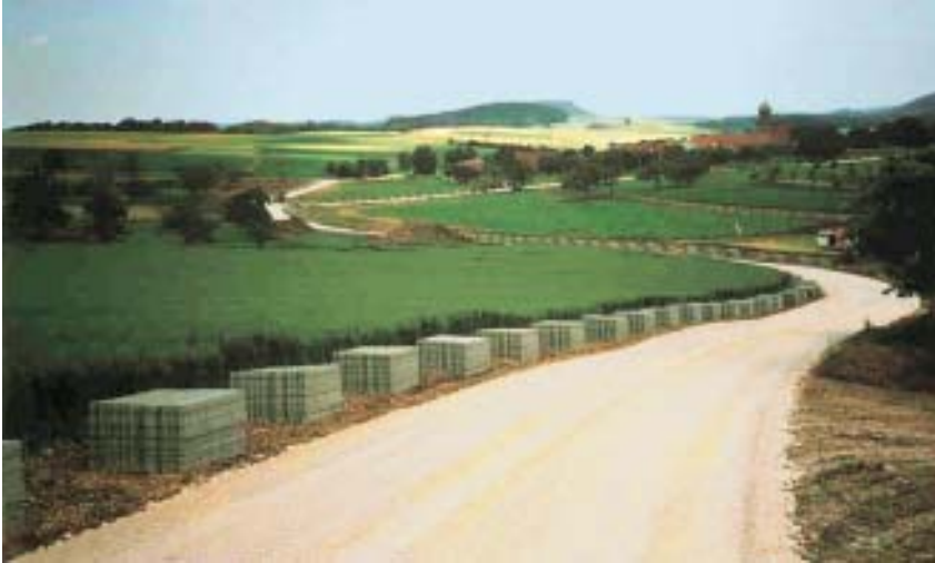
Anlieferung der Pflastersteine
