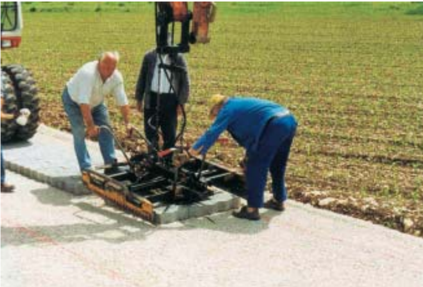
Arbeiten mit der Verlegezange
