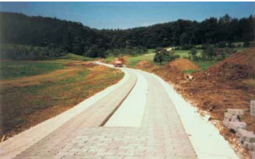
Pflaster fertig verlegt
