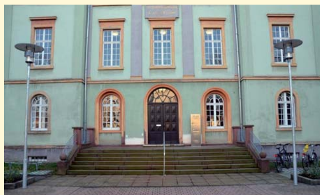
Eingang zum Dienstgebäude in Karlsruhe
